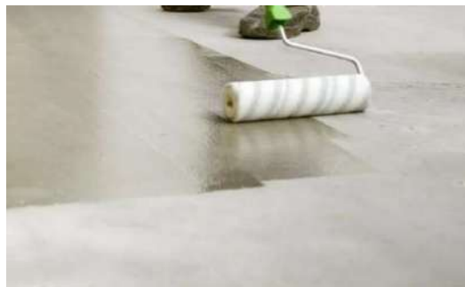
Рисунок 1 – Ручное нанесение грунта
