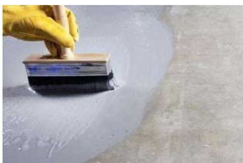
Рисунок 1 – Ручное нанесение грунта
