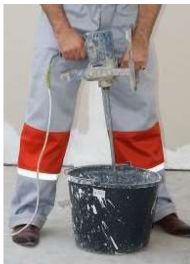
Рисунок 3 – Перемешивание смеси ручным электроинструментом
