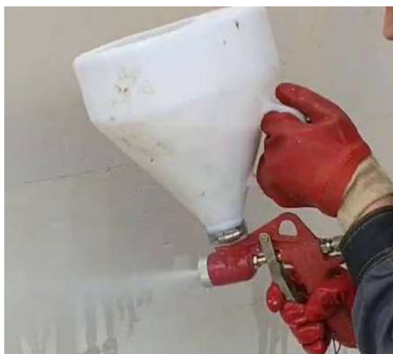
Рисунок 1 – Ручное нанесение грунта
